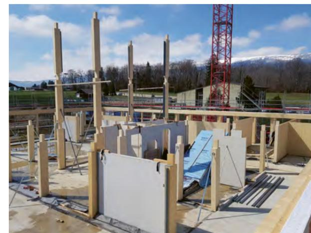
Assemblage acier-bois spécialement conçu pour absorber les tolérances locales pour le transfert de charge.
