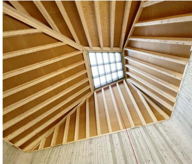
La coupole est composée d'éléments modulaires en bois et est recouverte de chaume.
