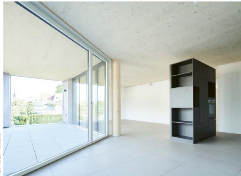
**Les dalles d'étage reposent sur des piliers en bois. Cela permet des espaces pouvant être utilisés de manière flexible, sans supports ni murs porteurs.**
