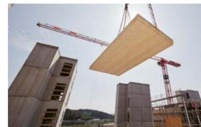
**Avant : Les noyaux des cages d'escalier étaient bétonnés au préalable. Il faut pour cela un échafaudage.**
