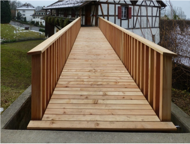
Die Holzbrücke bietet direkten Zugang zu den Museumsräumen
