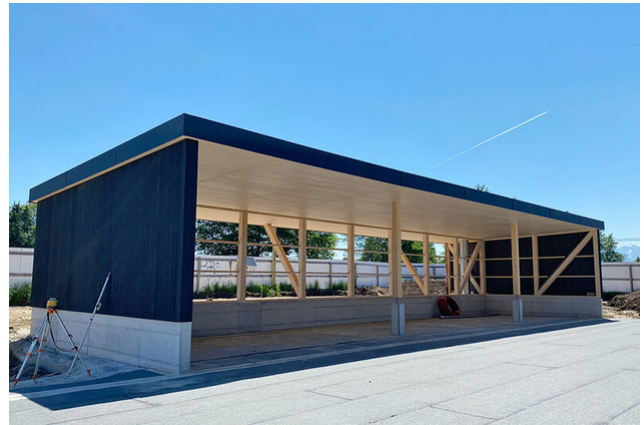
Überdachung des Containerhauses
