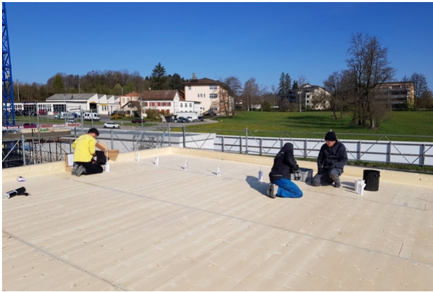
TS3 beim TS3-Verguss des Vordachs
