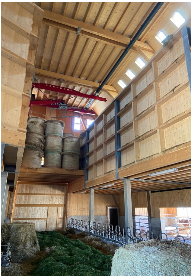
Aufhängung Heukran in der Scheune
