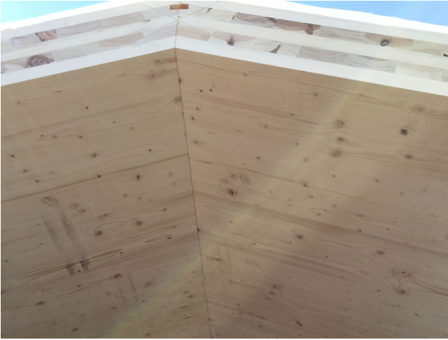
Momentaufnahme von den Bauarbeiten: Zusammenschnitt der Dachplatten im Firstbereich
