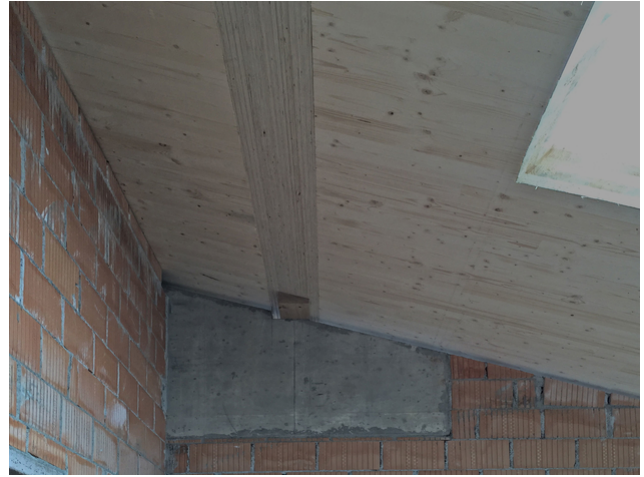
Von unten unsichtbar: Die Kerto-Mittelpfette wurde in den Dachaufbau integriert
