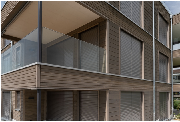
Holzfassade und Balkone im Aussenbereich
