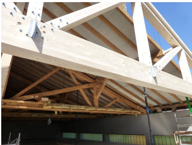
Alter und neuer Fachwerkbinder
