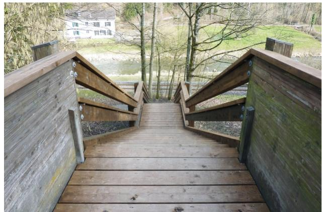
Die Horgener Fussgängerbrücke über die Sihltalstrasse musste zu grossen Teilen ersetzt werden. Viele zentrale Holzelemente der Querung waren in einem schlechten Zustand.
