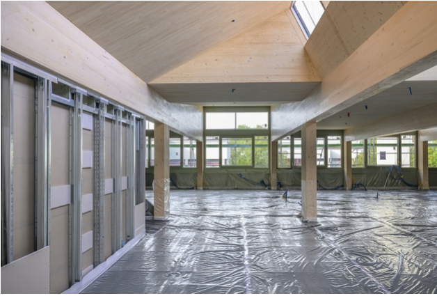
Innenansicht mit Holz-Konstruktion und akustisch wirksamen Lignotrend- Deckenelementen
