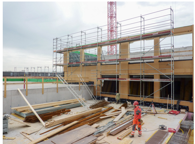
Holzelemente für die neue Schulanlage im Bau
