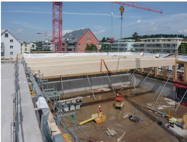
Einbau von Dachgepäckträgern für die neue Sporthalle
