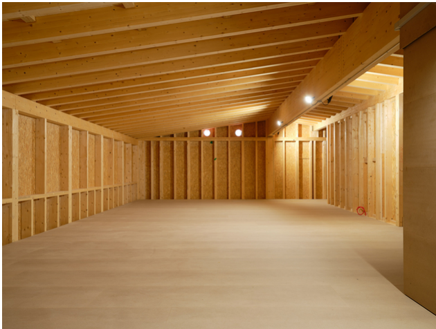
Dachgeschoss als Ausbaureserve mit vorbereiteten Fensteröffnungen
