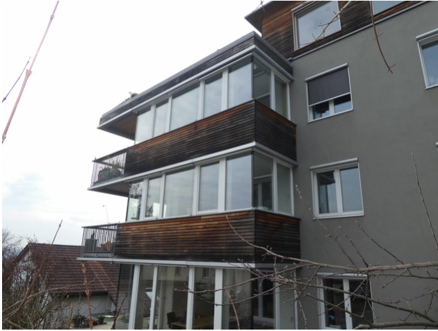
Fassade nach 10 Jahren
