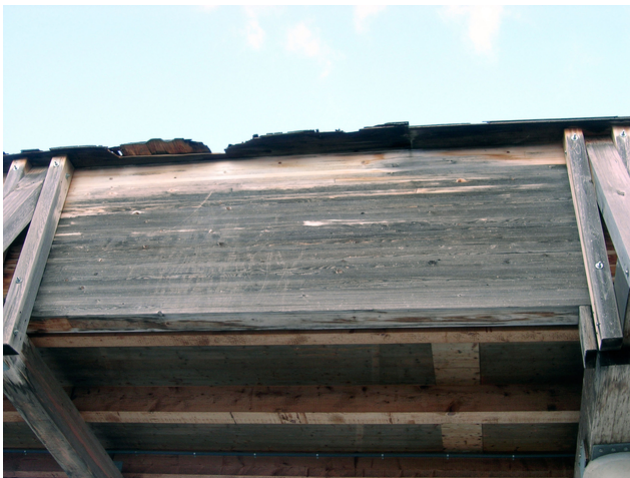
Fußgängerbrücke vor der Sanierung 2
