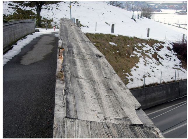
Fußgängerbrücke vor der Sanierung 1
