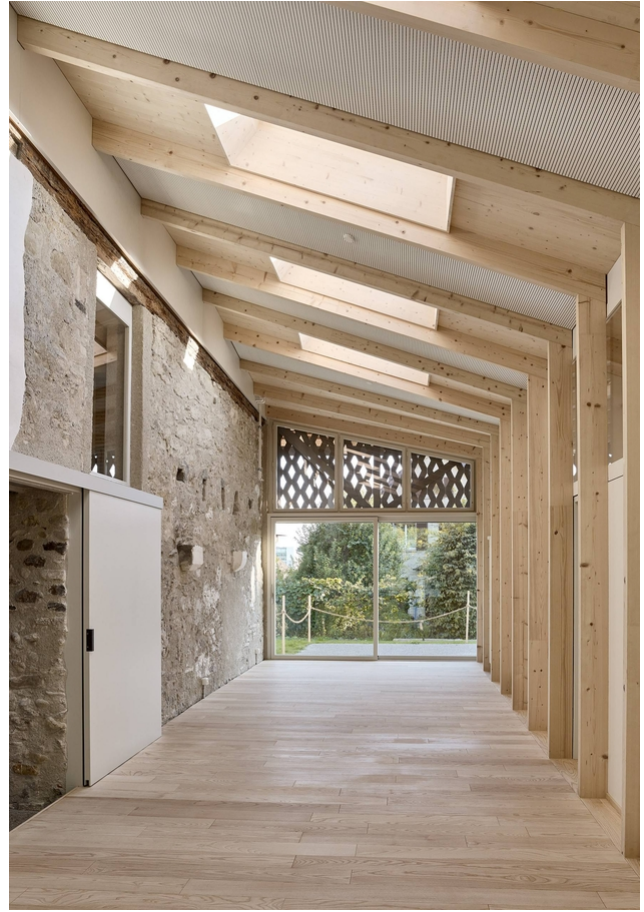
Übergang Altbau-Neubau (Fotos © Ariel Huber)
