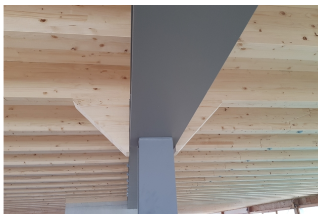
Kombination von Stahltragwerk und Holzbau
