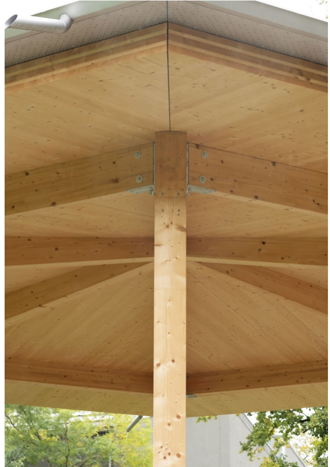
Sicht auf Eckpfosten inkl. Balkenanschlüssen
