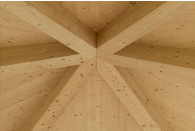
Dachuntersicht auf Brettsperrholz mit den zentral zusammenlaufenden Pfeften
