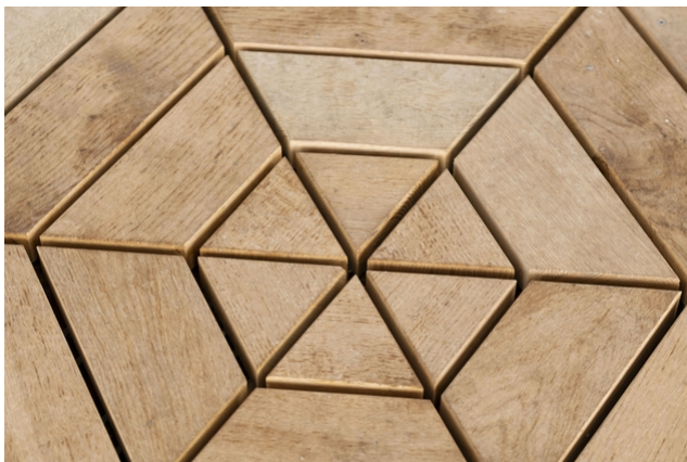
Holz Terrassendeck im Hexagon verlegt
