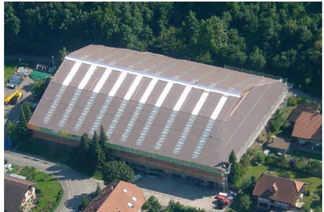
Über der bestehenden Zivilschutzanlage war eine Überdachung für die bisher offene Eisbahn zu erstellen. Die Baulinien liessen kaum Spielraum über die Gestaltung der Dachform zu. Nicht nur im Grundriss, sondern auch im Schnitt mussten Begrenzungen eingehalten werden.
