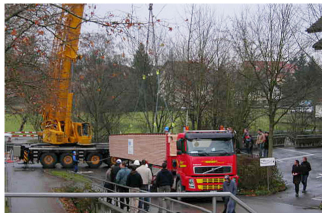
Montage vom Lkw aus
