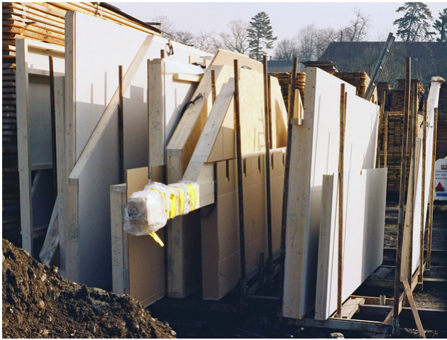
Lagerung der Wände
