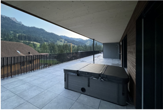
Durchlaufende TS3 Geschossplatten. Terrasse mit Sicht auf die prachttvolle Bergwelt des Entlebuch
