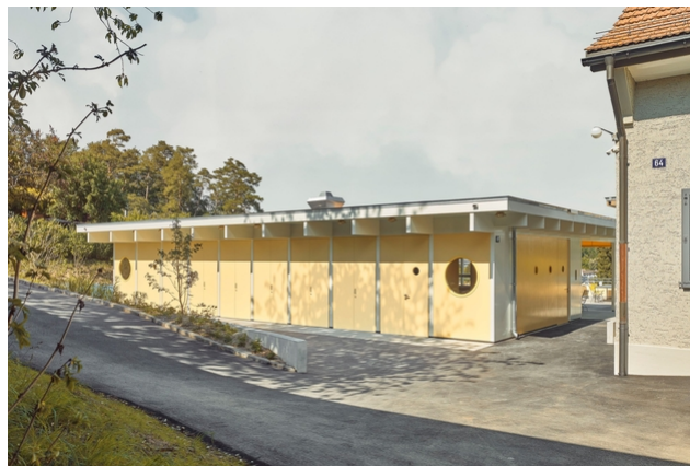
Ein grosses Vordach für den Witterungsschutz
