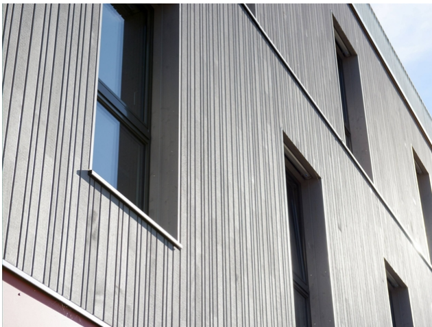
Vielseitig einsetzbar: Fassade mit Materialien aus dem OLWO-Programm
