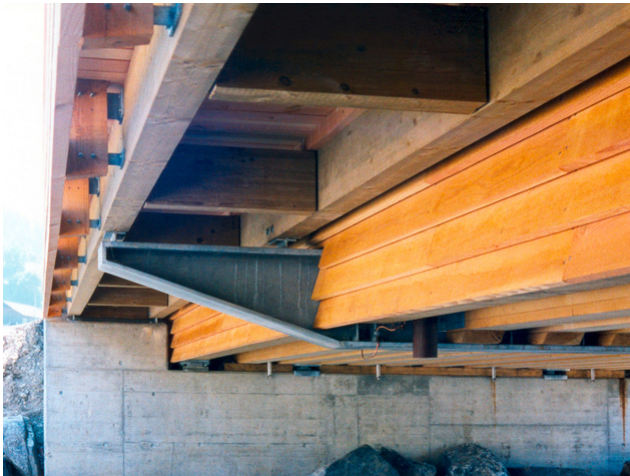
Eingebauter Stahlquerträger
