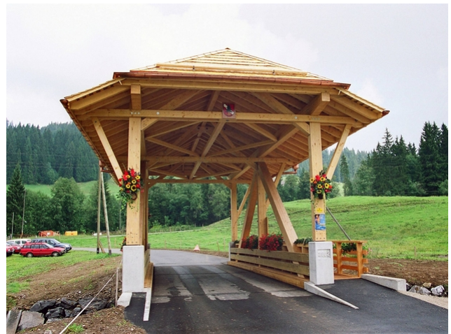
Blick auf die Brücke
