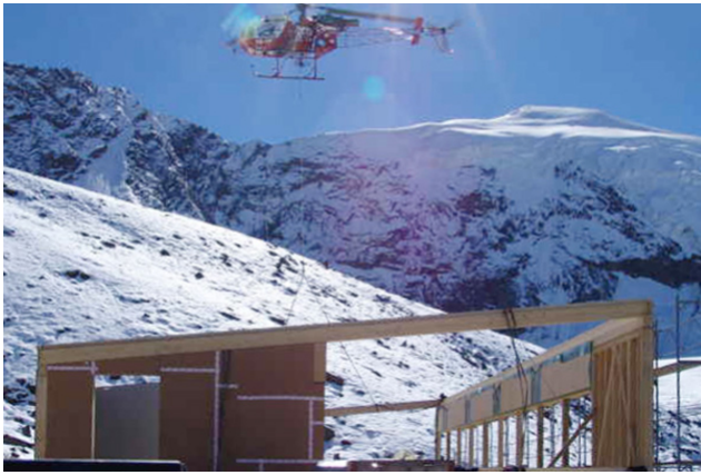
Aufrichten mit Helikopter
