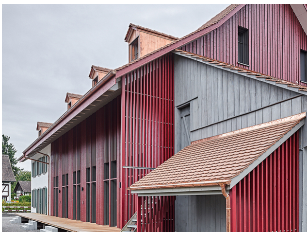
Die Holzschalung ist mit einer oxydrierten Öllasur gestrichen worden
