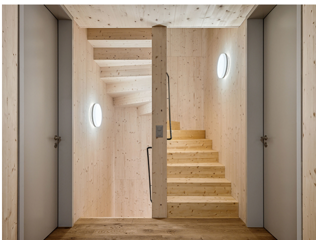
Ein Treppenhaus ganz aus Holz
