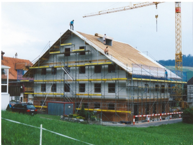
In der Bauphase
