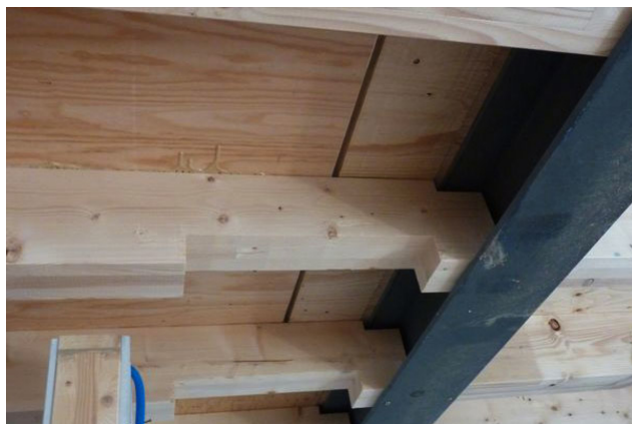
Ausschnitte für Haustechnikinstallationen in den Rippelementen der Geschossdecken
