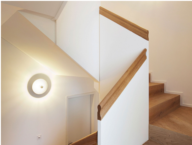
Sowohl die Treppenläufe als auch das Treppenpodest wurden in Holzbauweise ausgeführt
