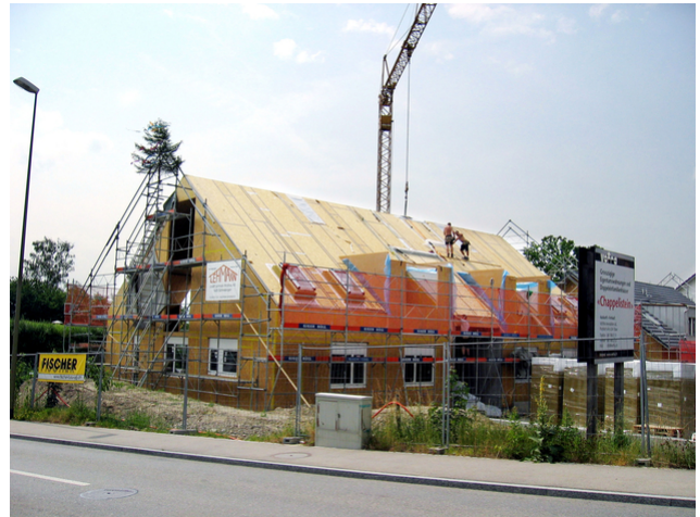
Vorbereitung Dachdämmung
