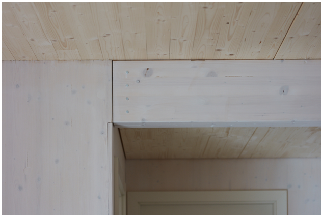
Unterzug mit eingepprägtem Stahlblech
