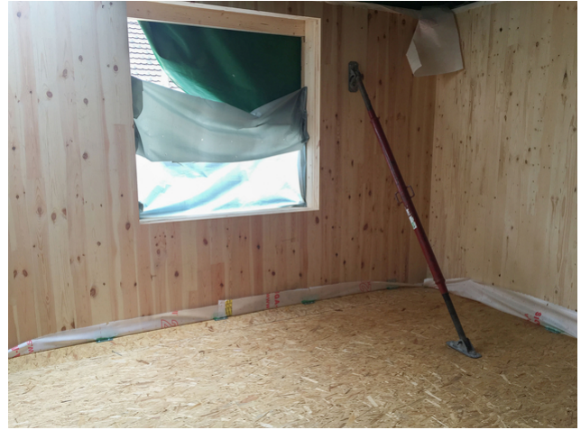
Während den Bauarbeiten: Tragende Aussenwände aus Massivholz
