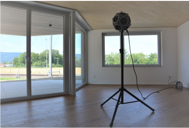
Ansicht Stützen-Plattenverbindung und Akustikmessungen
