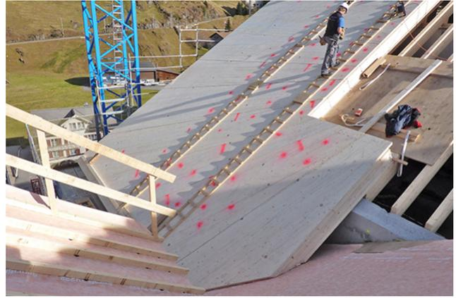
Montage von Dachelementen auf der Primärkonstruktion
