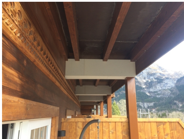
HEB Träger verkleidet
