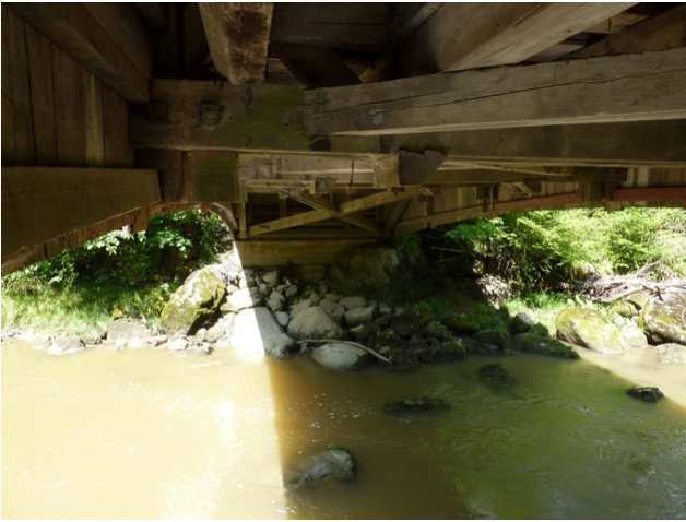
Untenansicht der Brücke
