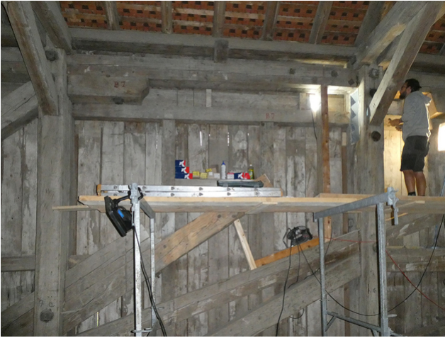
Strebensanierung der Brücke
