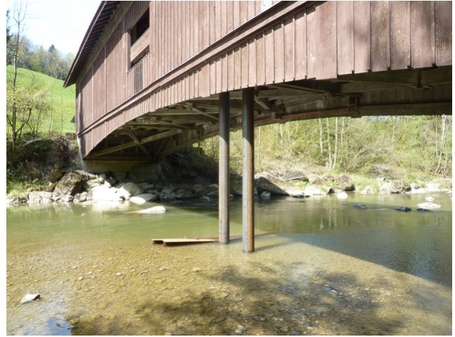
Provisorische Rammfähle zur Stabilisierung
