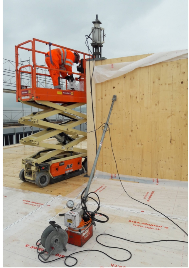
Vorspannen, Bild Timbatec AG
