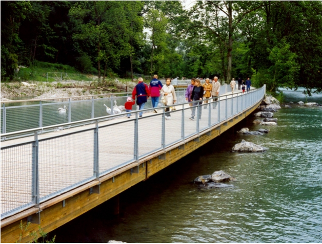
Fußgängerweg in Betrieb
