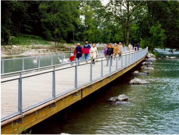
Fußgängerweg in Betrieb
