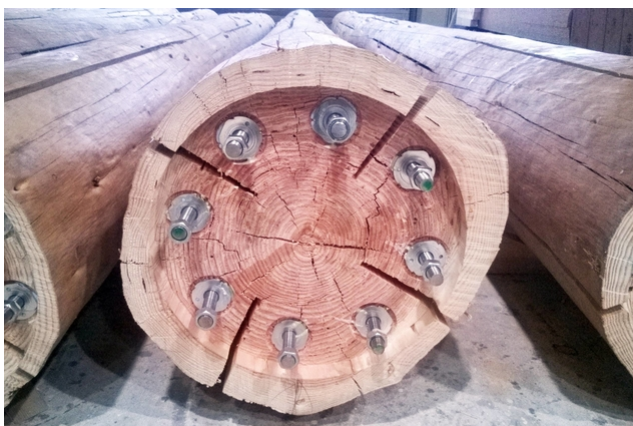
Eingeklebte Gewindestangen
