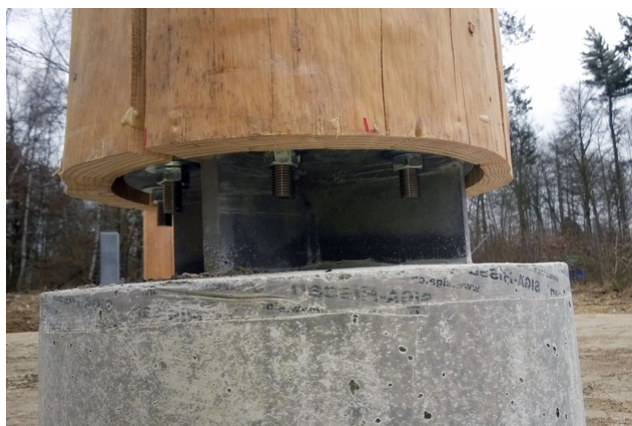
Montierter Stützenfuss
