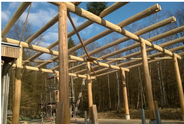
Tragwerk nach Montage
