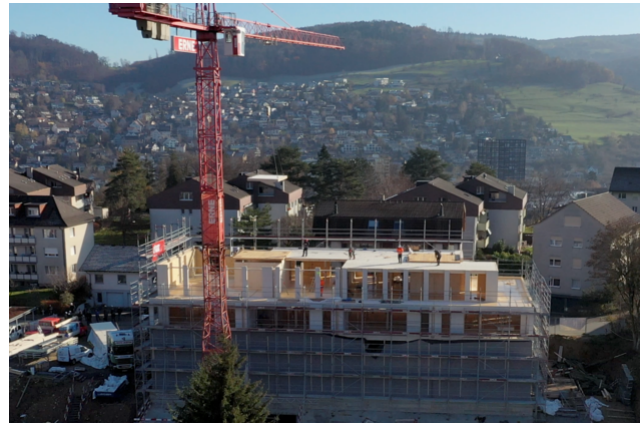
Der Fasanehof während seiner Erstellung
