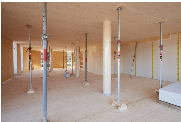
Während dem Aushärten des Giessharzes müssen die Geschossdecken zusätzlich abgestützt werden
