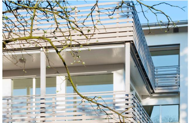
Das bestehende Mehrfamilienhaus an der Salvatorstrasse wurde einer Gesamtsanierung unterzogen, um mehr Raum, Komfort und Ästhetik zu schaffen. Die Wohnraumerweiterung besteht aus Hohlkastenelementen, die frontseitig auf einer Pfosten- und Pfettenkonstruktion ruht und mit einer Glasfront bekleidet ist.
