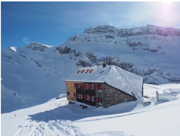
Extra stark: das Dach muss enorme Schneemengen tragen können
