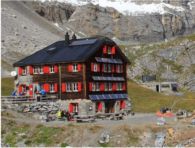
Die Lämmerenhütte vor der Erweiterung
