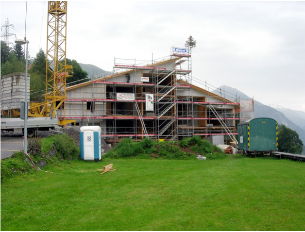
Rohbau des Gebäudes
