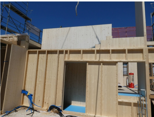
Montage der Holzbauelemente
