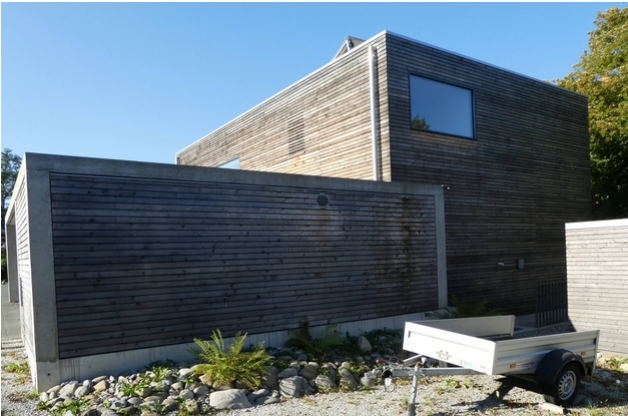
Fassade nach 5 Jahren
